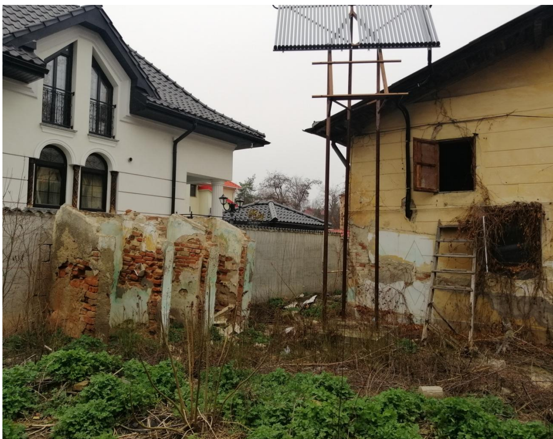
Vedere fațada posterioară
