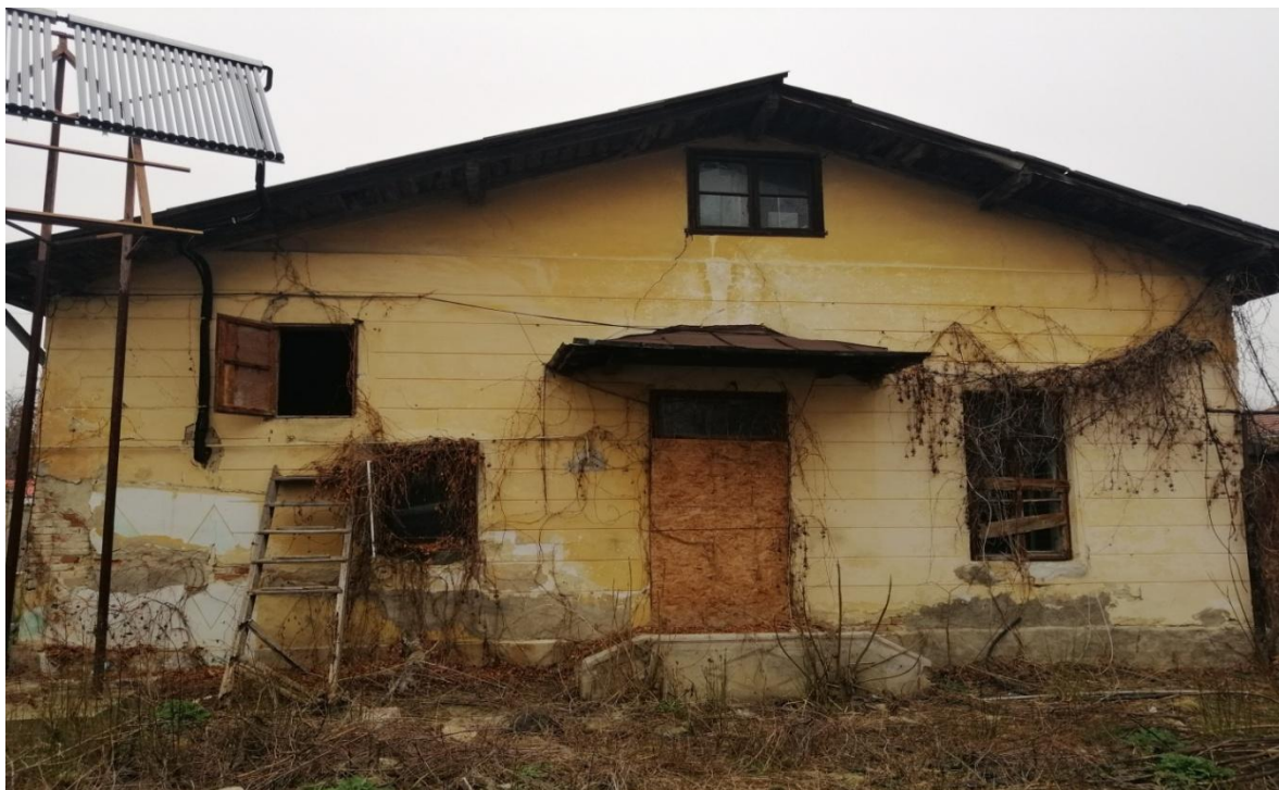
Vedere fațada posterioară
