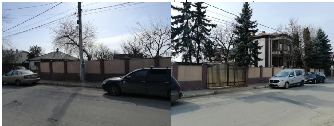
Vedere stradală către proprietate din Str. Pușkin
