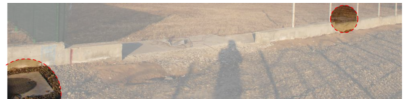
Fotografie 4 din 15.03.2022 Branșament existent - canale apă existente
