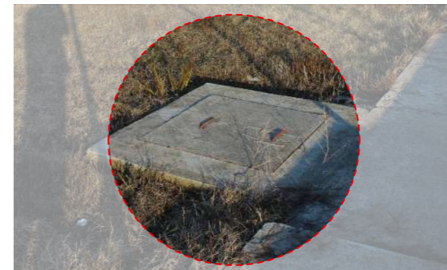
Fotografie 2 din 15.03.2022 Branșament existent - canal apă existent
